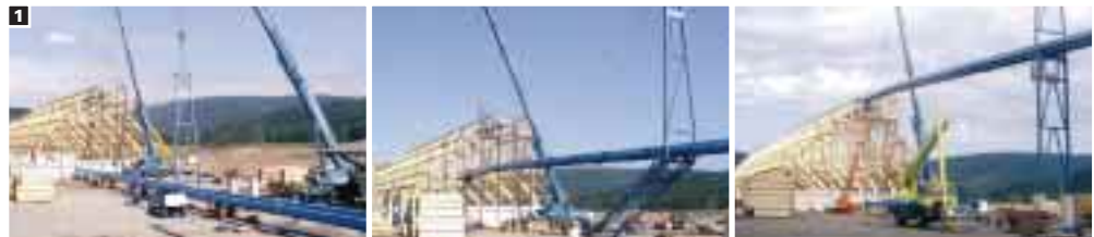
Монтаж на земле
