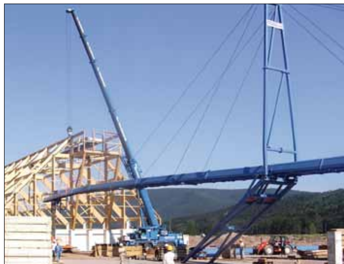
Lyft av förmonterade sektioner
