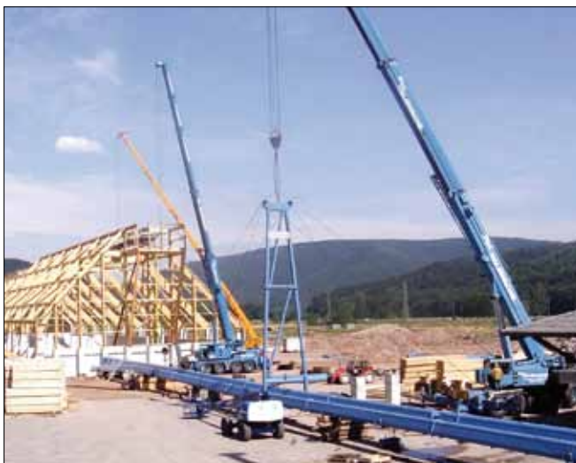
Montage på marknivå
